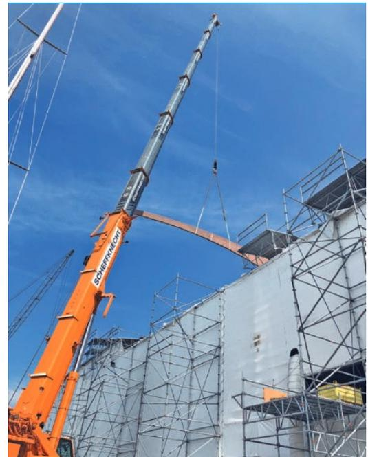
Bei Schönwetter wurde das Dach des Endfertigungszelts in Fußach entfernt, um die Einzelteile per Kran auf Position zu bringen, wo sie schließlich zusammengesweißt wurden.
