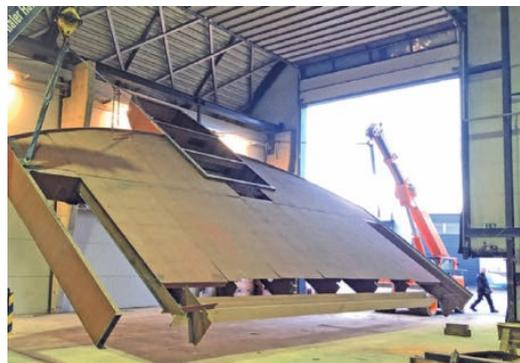
Das größte der 26 Segmente misst 13x10 Meter. Das Hallentor musste mit dem Schneidbrenner „erweitert“ werden, damit manche Einzelteile auf den Schwertransporter gehievt werden konnten.
