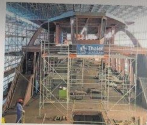
Dimensionen des Aufbaudecks: 50 Meter lang, 14 Meter breit und zehn Meter hoch. STP
