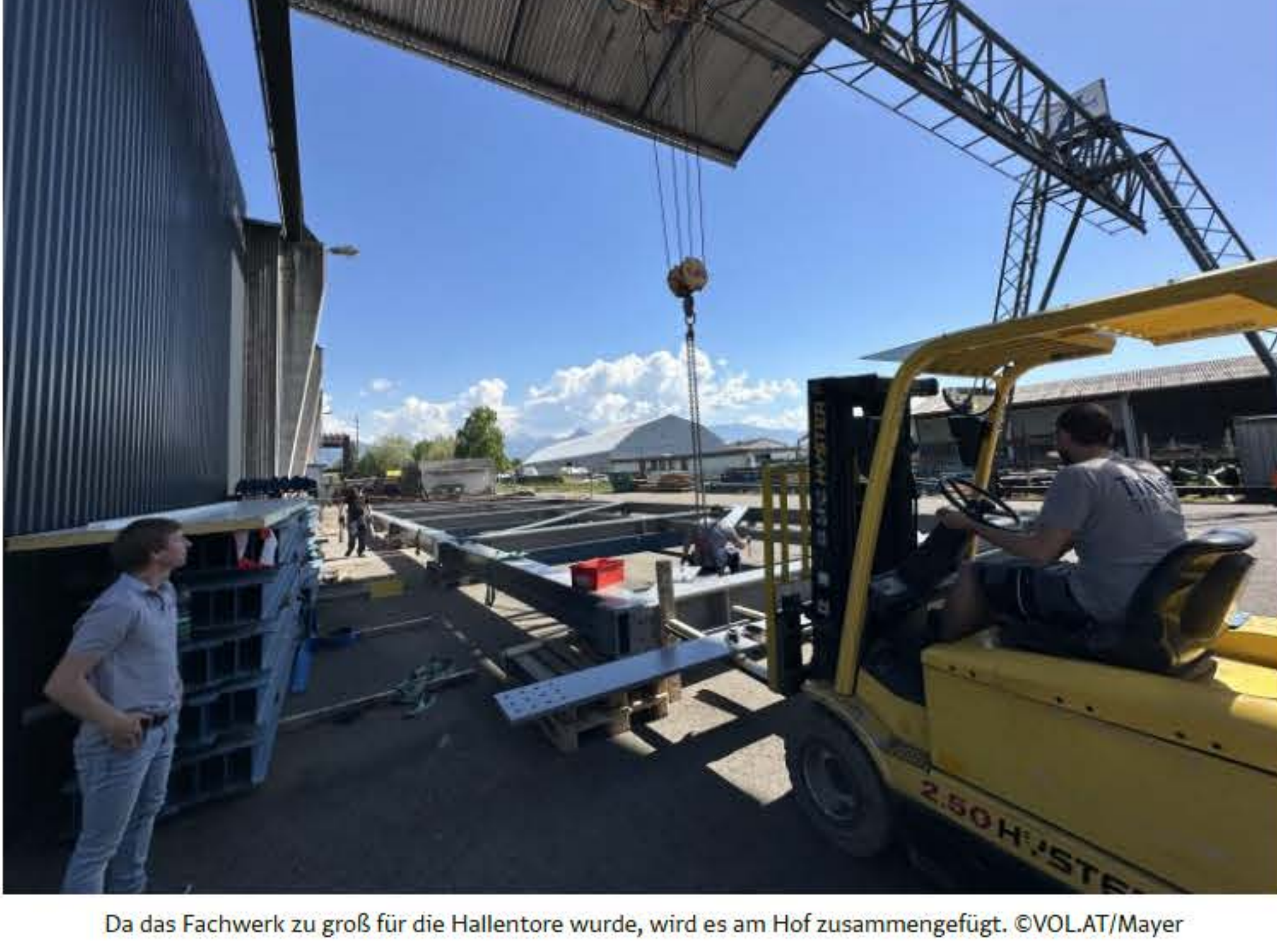
Da das Fachwerk zu groß für die Hallentore wurde, wird es am Hof zusammengefügt. ©VOLAT/Mayer
